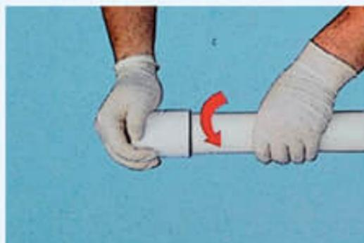
3. Плотно вставьте трубу в фитинг до упора и проверните на ¼ оборота.
