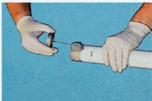
2. Используя кисть (аппликатор), нанесите тонкий слой клея на скрепляемые поверхности.
