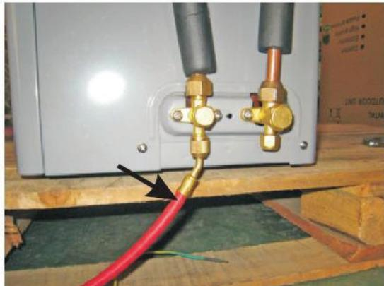
4. Другой конец трубки манометра подключите к коннектору хладагента высокого давления наружного блока.
