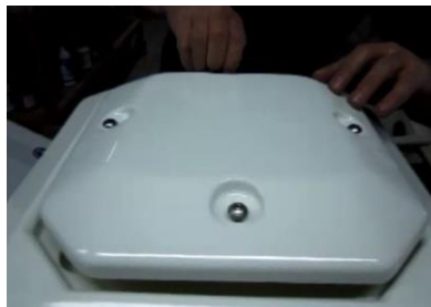
4. Posicione tornillos y separadores. Unos tornillos (largos) se enroscan en el sumidero, otros (cortos) apoyan con el casquillo ciego | Place the screws. A part (the long ones) will fix the lid to the drain, other part (the short ones) will be only screwed into the nylon cup.
