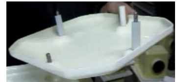
4. Posicione tornillos y separadores. Unos tornillos (largos) se enroscan en el sumidero, otros (cortos) apoyan con el casquillo ciego | Place the screws. A part (the long ones) will fix the lid to the drain, other part (the short ones) will be only screwed into the nylon cup.
